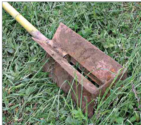
Obr. 7.8. Túto kotvu turista nevidí, ale vyniesť ju treba aj so smerovníkom (Foto: Žilinskí značkári)
