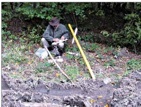
Obr. 7.36. A keď vám lesný traktor urobí toto, treba začať odznova. Demontovať smerovky, vyhlbiť novú dieru, osadiť smerovník, namontovať smerovky... A život ide ďalej.
