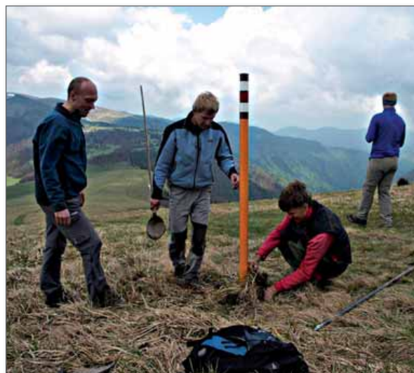
Obr. 7.17. Po fixovaní kameňmi treba jamu zasypať a pôdu okolo kola pevne ubiť (Foto: Marti Kleskeň)
