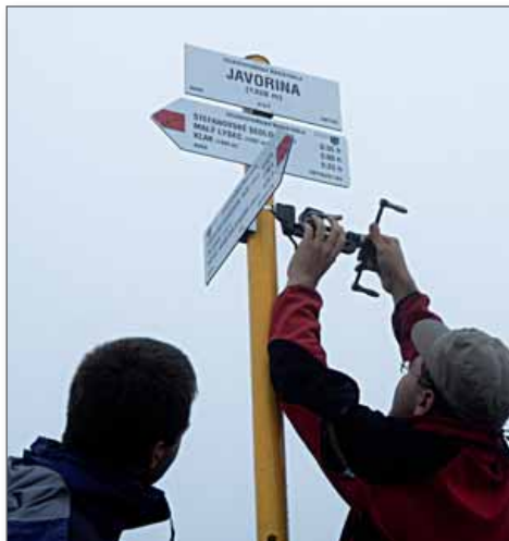
Obr. 7.21. Pripevňovanie smeroviek sťahovacou páskou (Foto: Michal Vajda)
