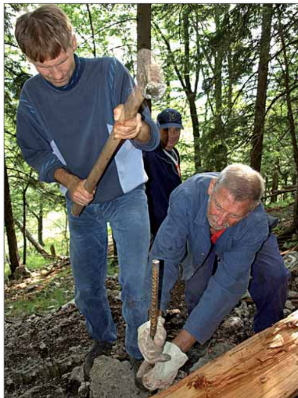
Obr. 7.33. Budovanie schodov patrí k tým ťažším prácam (Foto: Martin Kleskeň)
